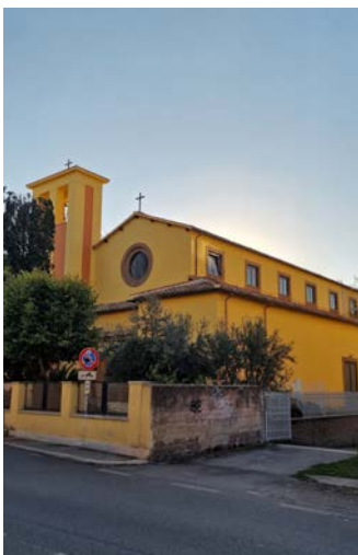
La nostra chiesa del SS. Crocifisso, finalmente ristrutturata! - ottobre 2026
